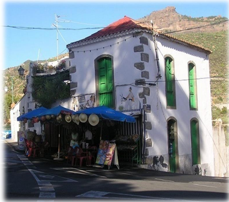
Foto vivienda estado actual
